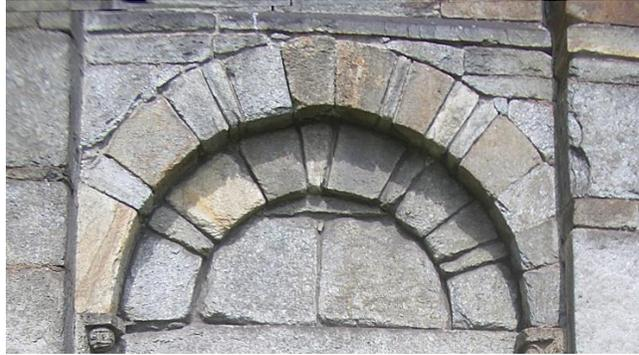
Darstellung des oben beschriebenen Systems mit Trapez/Keilförmigen Steinen
